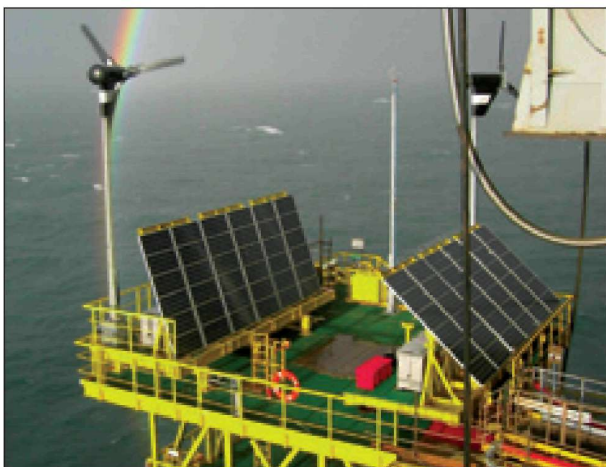
Рис. 1. Представление базовой платформы Shell на юге Северного моря, установленной в 2006 г. Ветряные и солнечные устройства питают базовую платформу и установлены просто по коммерческим причинам (Sweeney, личн. беседа). Сама установка была основана на технологии прибрежной ветровой электростанции.
