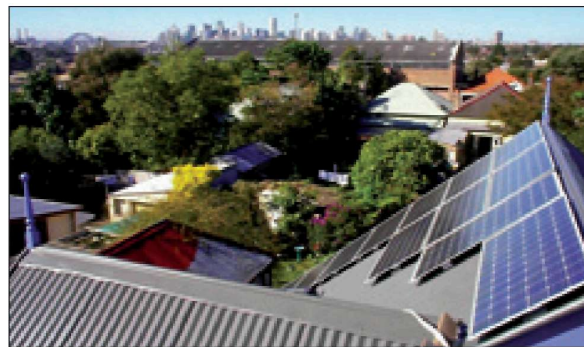
Рис. 2. Солнечные панели BP Solar, установленные на крыше Олимпийской Деревни в Сиднее, Австралия. Фотоэлектрическая станция, соединённая с электросетью, отводит энергию назад в электрическую сеть в течение дня и берет из сети ночью, делая его наиболее быстро растущим рынком ФЭ.
