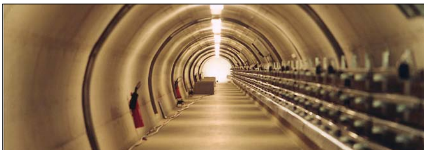
Túnel de monitorización geofísica del Observatorio de Conrad.
